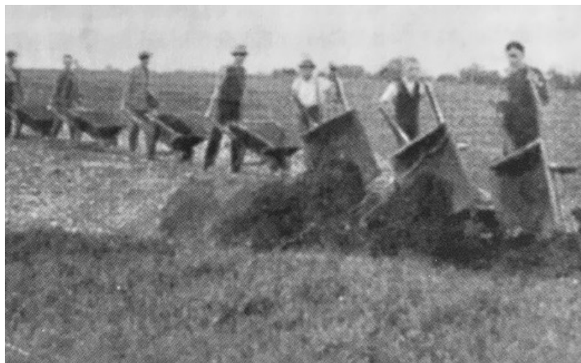
36 drenge og mænd påbegyndte den 12. maj 1924 gravearbejdet til KFUMs idrætsplads.
