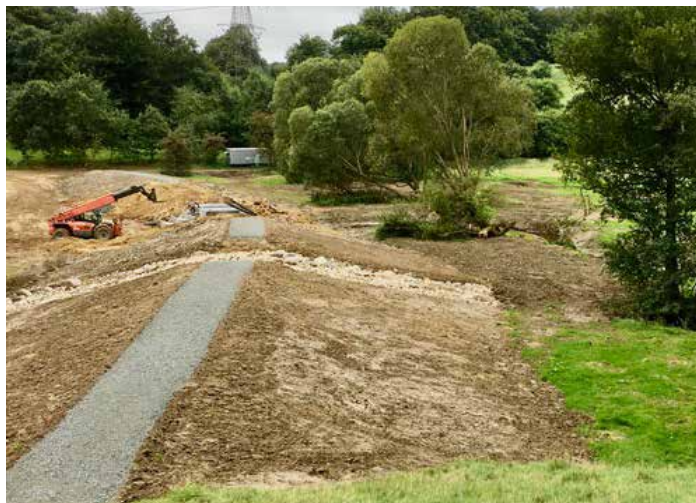
Hylkedalen - det er efterhånden til at se, hvordan området kommer til at se ud, når diget er etableret færdigt
