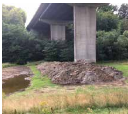
Arbejdet er i fuld gang med anlæggelse af digerne, ændring åens forløb og en ny sø
